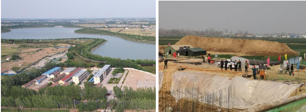
图 1.5-4 高河水厂、金南水厂建设
