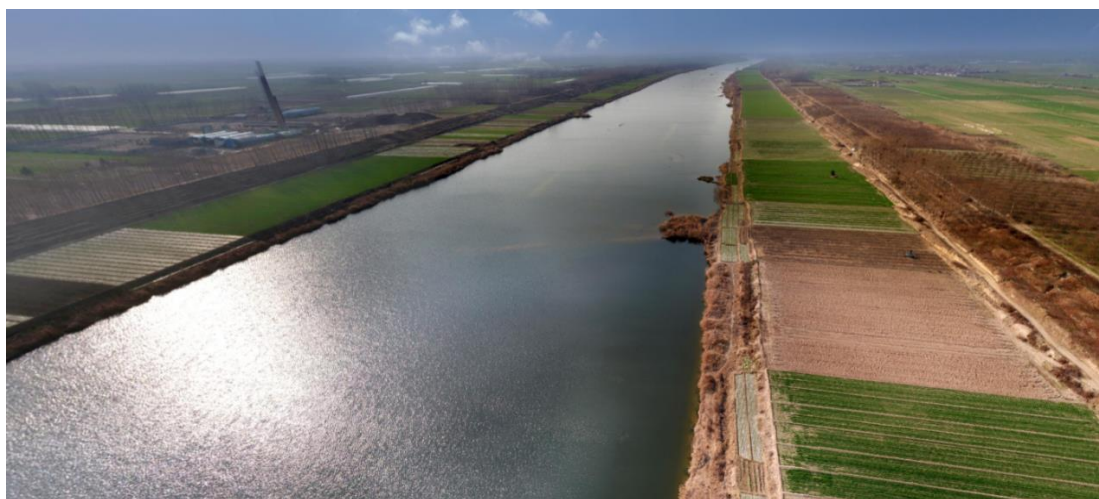
图 1.2-2 东鱼河现状情况
