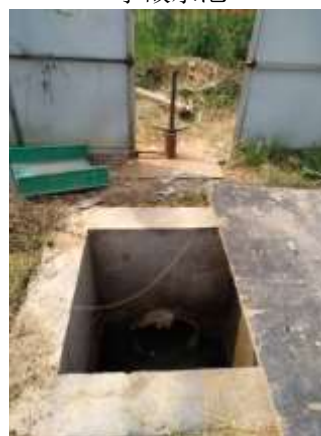
雨水总切断阀
